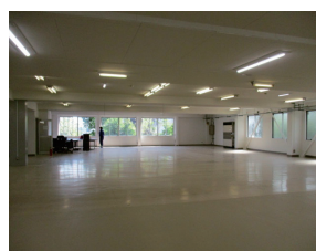
4F内装工事中
