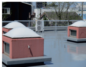
屋上防水工事実施
