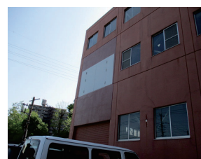
3Fに搬入口設置
